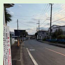
再舗装が進む旧県道
